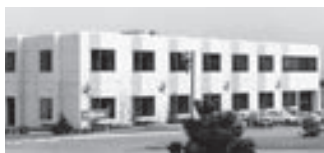
Завод Viessmann в Ватерлоо (Канада)
