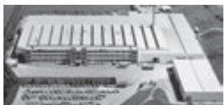
Завод Viessmann в Хоффе
