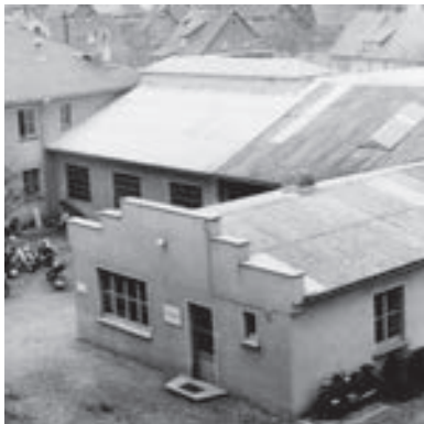
Заводской корпус в г. Аллендорфе
