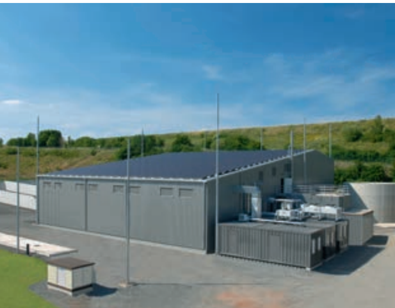
Биогазовая установка Viessmann
