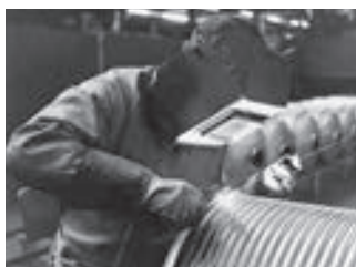
Сварка змеевиков накопителя
