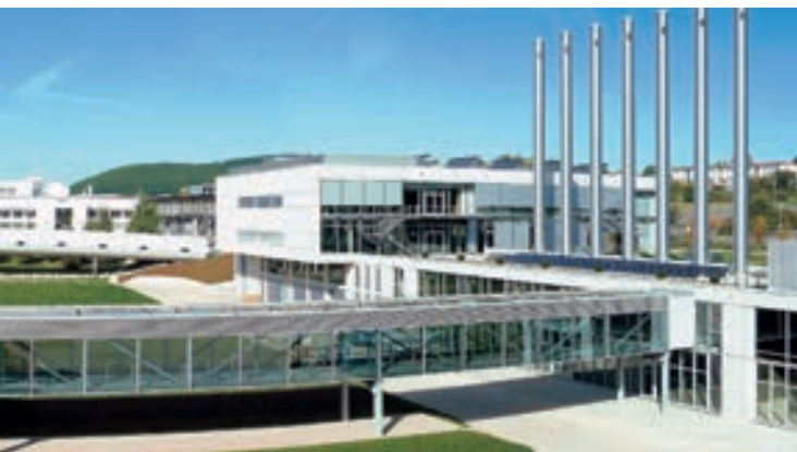
Информационный центр и производственные цеха Viessmann в г. Аллендорф.
