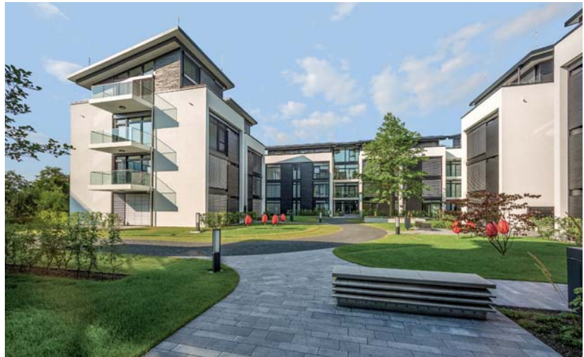
Wärmeverteilung in Quartieren – effizient und wirtschaftlich.
