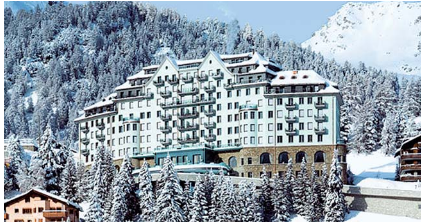
Im 5-Sterne-Hotel Carlton in St. Moritz wird das Abwasser zur Wärmegewinnung genutzt.
