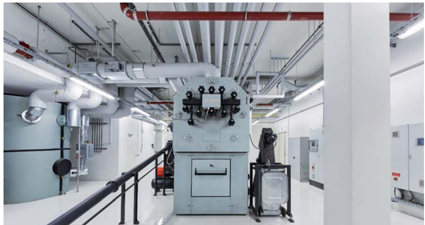
Holzpelletkessel Vitoflex 300-UF mit einem Wärmeleistungsbereich von 300 bis 950 kW
