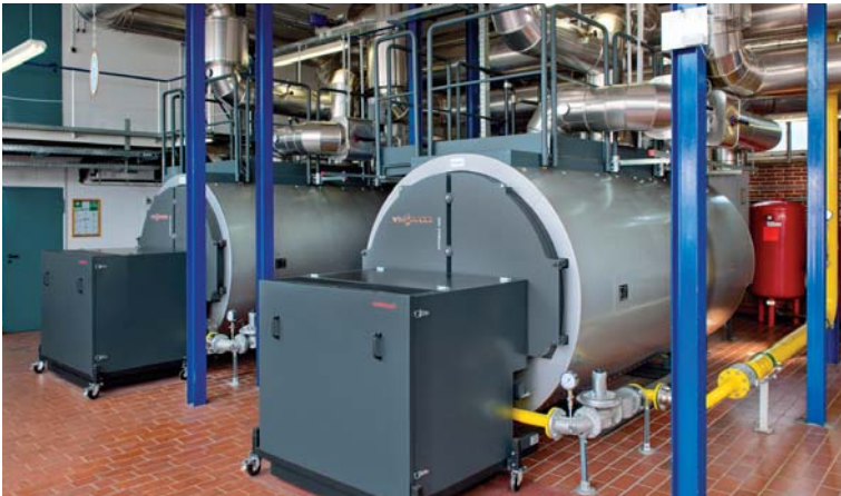
Die Vitomax 200 LW leisten je 2,3 MW.
