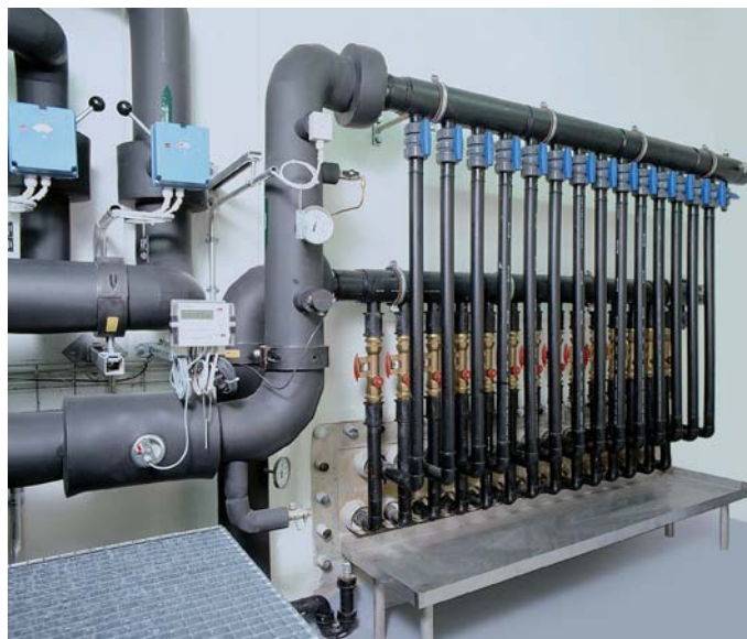
Erdsondenverteiler
