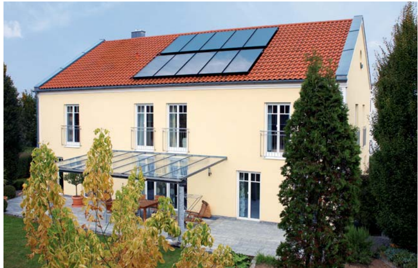
Vitosol 200-FM Zweifamilienhaus Geisenfeld
